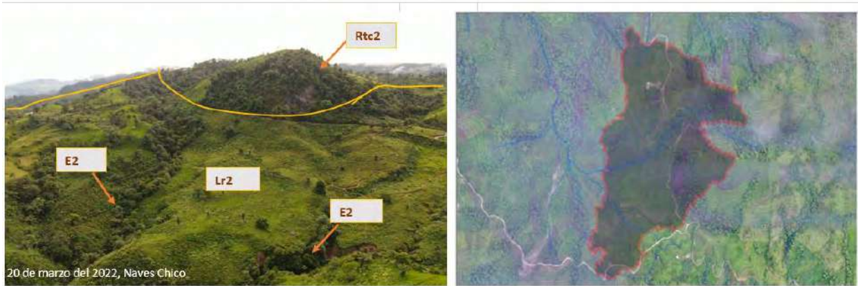
Figura 5-80 Relieve colinado y vertiente heterogénea sector Naves Chico, El Domo - Proyección Infraestructura Tajo Abierto de Mina
