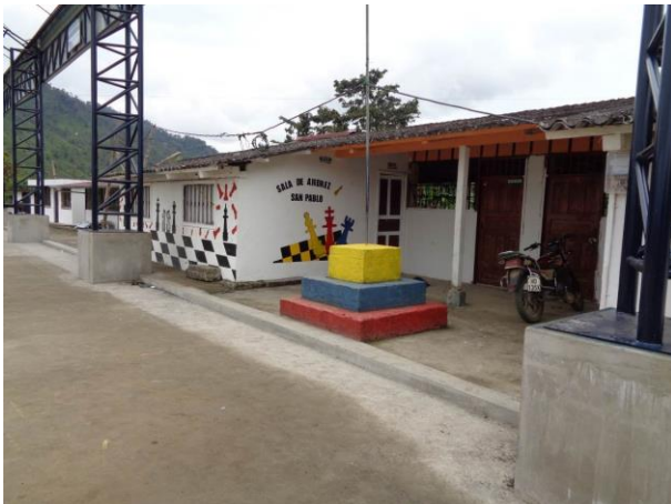
Fotografía 6.3-23: Recinto San Pablo de La Plata – Escuela Teniente Edmundo Chiriboga – Aulas de estudio. Fecha: 30-08-2021
