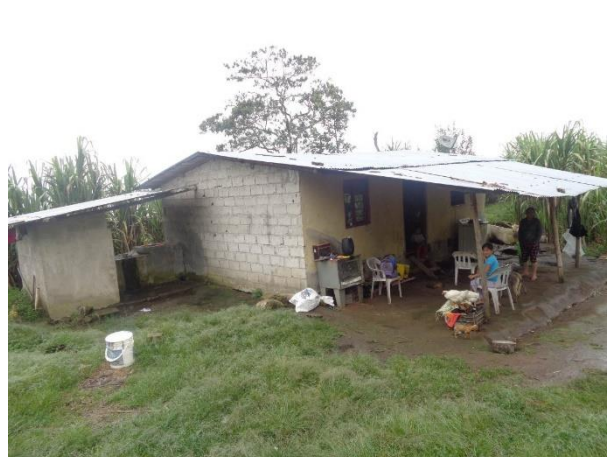
Fotografía 6.3-40: Recinto Las Minas de La Plata – Vivienda Rubén Santiago Díaz. Fecha: 01-09-2021
