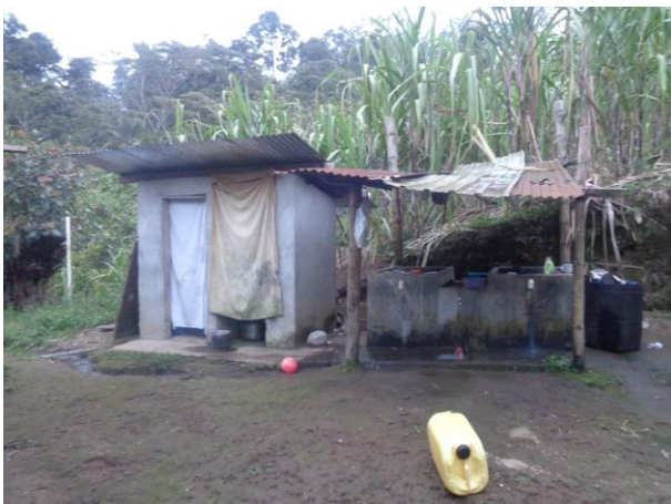
Fotografía 6.3-91: Recinto San Pablo de La Plata – Servicio Higiénico. Fecha: 30-08-2021
