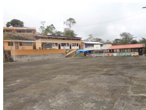
Fotografía 6.3-20: Cabecera parroquial Palo Quemado – Escuela Juan Salinas – vista general. Fecha: 02-09-2021
