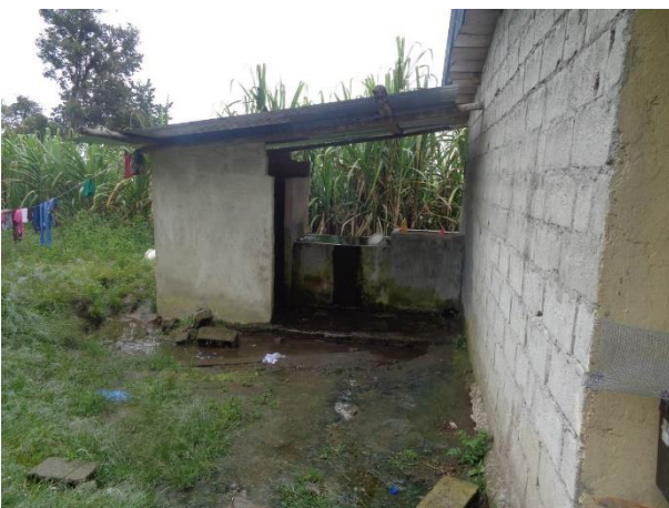
Fotografía 6.3-99: Recinto Las Minas de La Plata – Vivienda Rubén Santiago Díaz. Fecha: 01-09-2021
