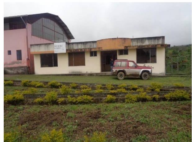
Fotografía 6.3-14: Centro de Salud Palo Quemado – vista general. Fecha: 02-09-2021
