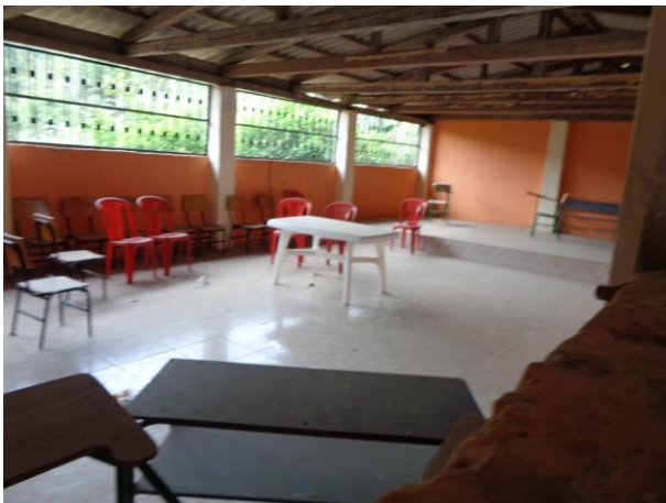
Fotografía 6.3-25: Recinto San Pablo de La Plata – Escuela Teniente Edmundo Chiriboga – Aulas de estudio. Fecha: 30-08-2021
