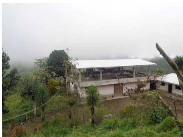
Fotografía 6.3-39: Recinto Las Minas de La Plata – Vivienda Jorge Vinicio Acosta Gómez. Fecha: 01-09-2021
