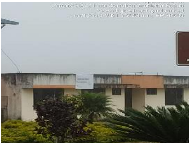
Fotografía 6.3-13: Centro de Salud Palo Quemado – Vista general. Fecha: 02-09-2021
