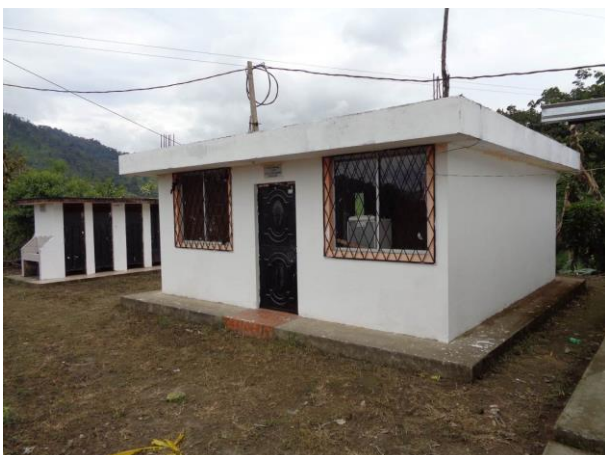
Fotografía 6.3-27: Recinto San Pablo de La Plata – Escuela Teniente Edmundo Chiriboga: vivienda del docente. Fecha: 30-08-2021
