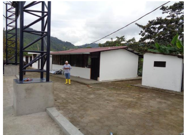
Fotografía 6.3-24: Recinto San Pablo de La Plata–Escuela Teniente Edmundo Chiriboga – Aulas de estudio. Fecha: 30-08-2021
