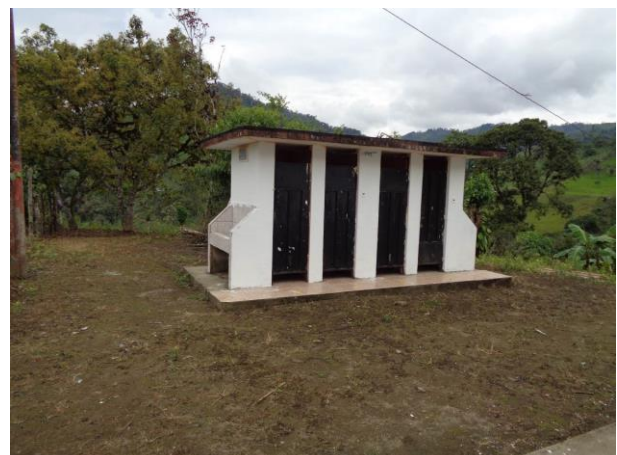
Fotografía 6.3-28: Recinto San Pablo de La Plata –Escuela Teniente Edmundo Chiriboga: baños Fecha: 30-08-2021
