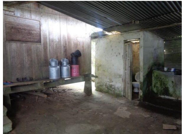
Fotografía 6.3-90: Recinto San Pablo de La Plata – Servicio Higiénico. Fecha: 30-08-2021
