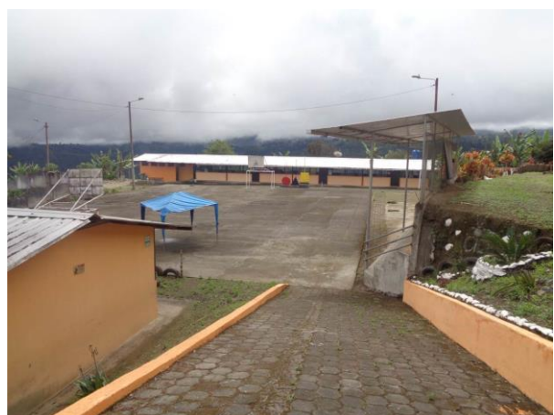
Fotografía 6.3-19: Cabecera parroquial Palo Quemado – Escuela Juan Salinas – vista general. Fecha: 02-09-2021
