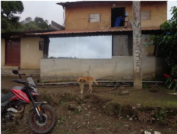
Fotografía 6.3-65: Recinto Las Minas –Tienda de Víveres. Fecha: 01-09-2021
