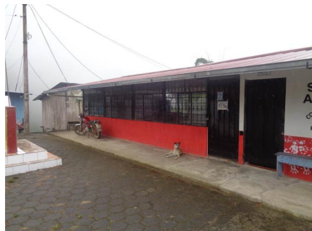
Fotografía 6.3-30: Recinto Las Minas de La Plata –Escuela: Gonzalo Rubio Orbe – Aulas. Fecha: 01-09-2021
