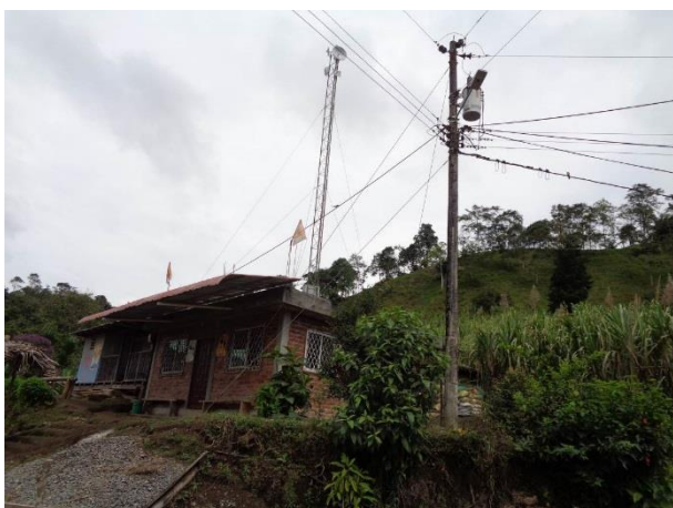
Fotografía 6.3-55: Recinto San Pablo de La Plata – Antena de Internet de la Empresa Mega Speed. Fecha: 30-08-2021
