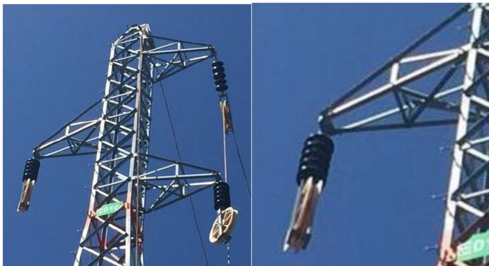
Figura 7-18 Colocación de poleas de tendido
