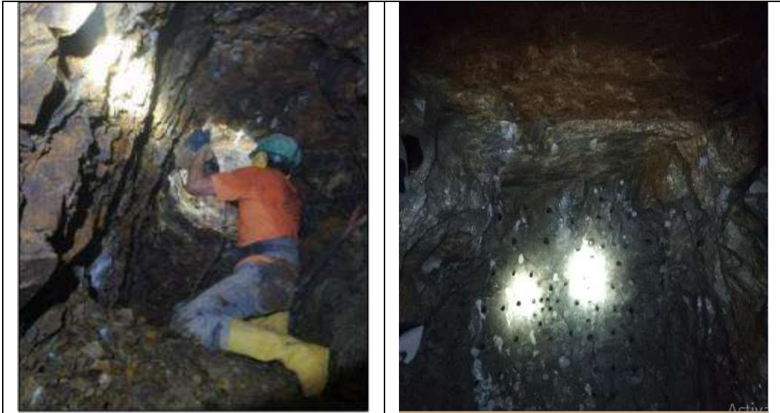
Fotografía 1.4. Perforación eléctrica y neumática
