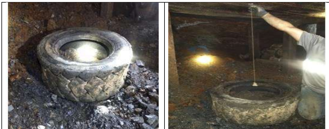
Fotografía 1.12. Nivelado de piso base, colocación y centrado de neumático.
