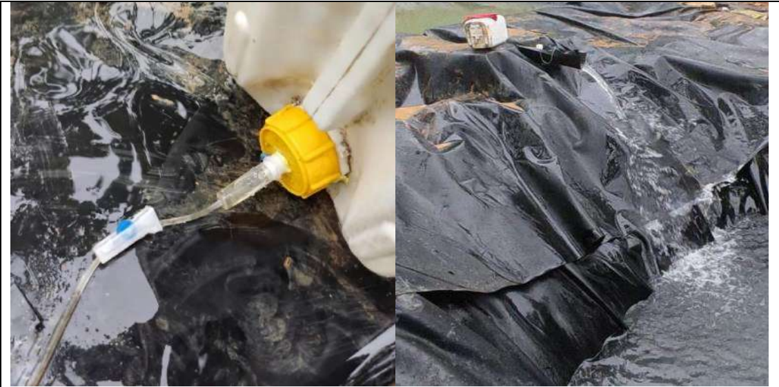
Fotografía 1.56. Sistema de dosificación y mezcla de coagulante
