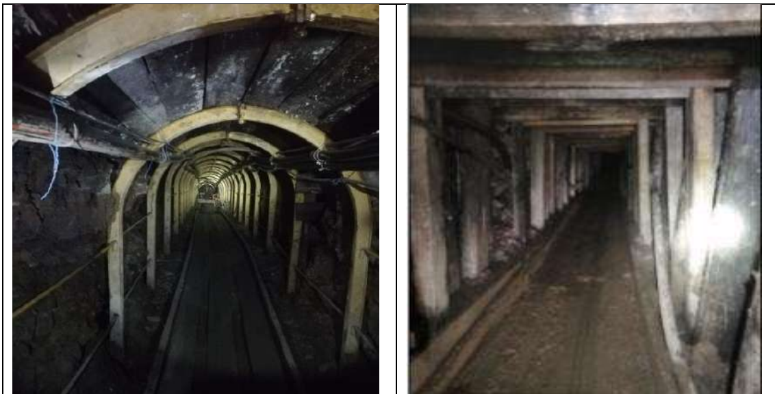
Fotografía 1.8. Fortificación de la bocamina
