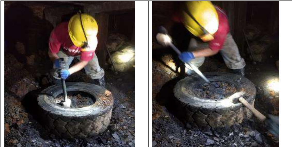
Fotografía 1.13. Relleno y pisoneado de aglomerado
