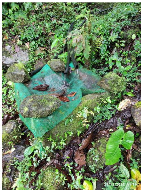
Foto 2. Captación de agua para uso doméstico
