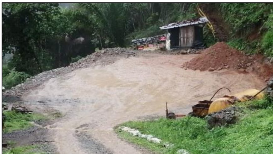
Foto 17. Área en canchamina destinada para stock del mineral
