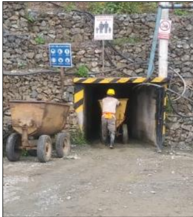
Foto 15. Fortificación de la bocamina
